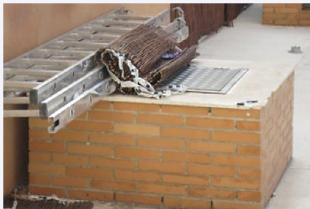
Vista exterior de la entrada al vaso de expansión
